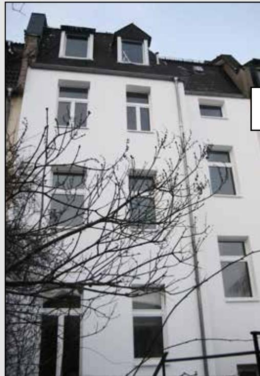
...Das Gründerzeitgebäude wurde hofseitig mit einem Wäredämm-Verbund-System isoliert. Die Strassenfassade steht unter Denkmalschutz und wurde nicht gedämmt.
